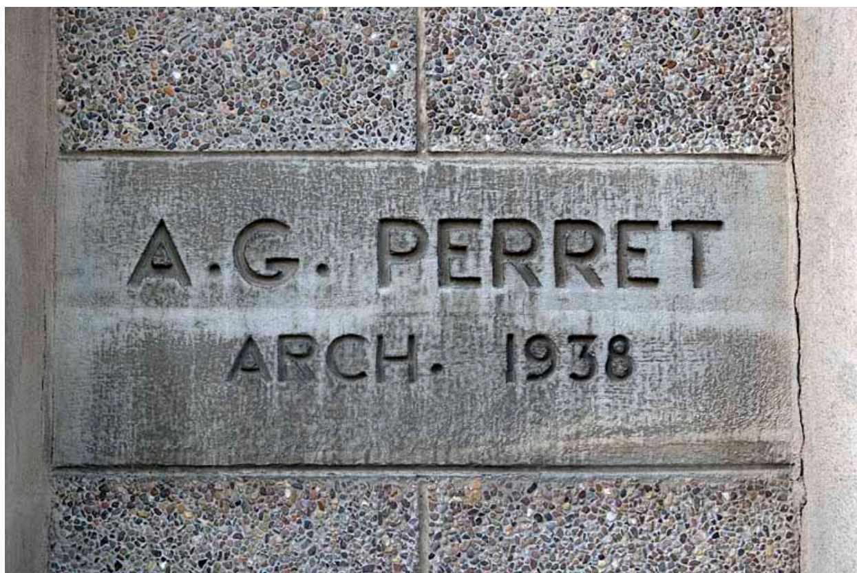
Façade antérieure : signature de l'architecte et date.
