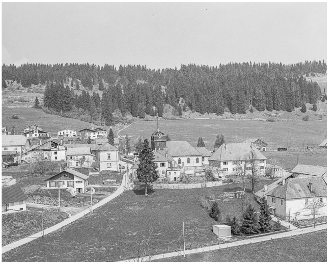
Vue de l'église dans le village.
