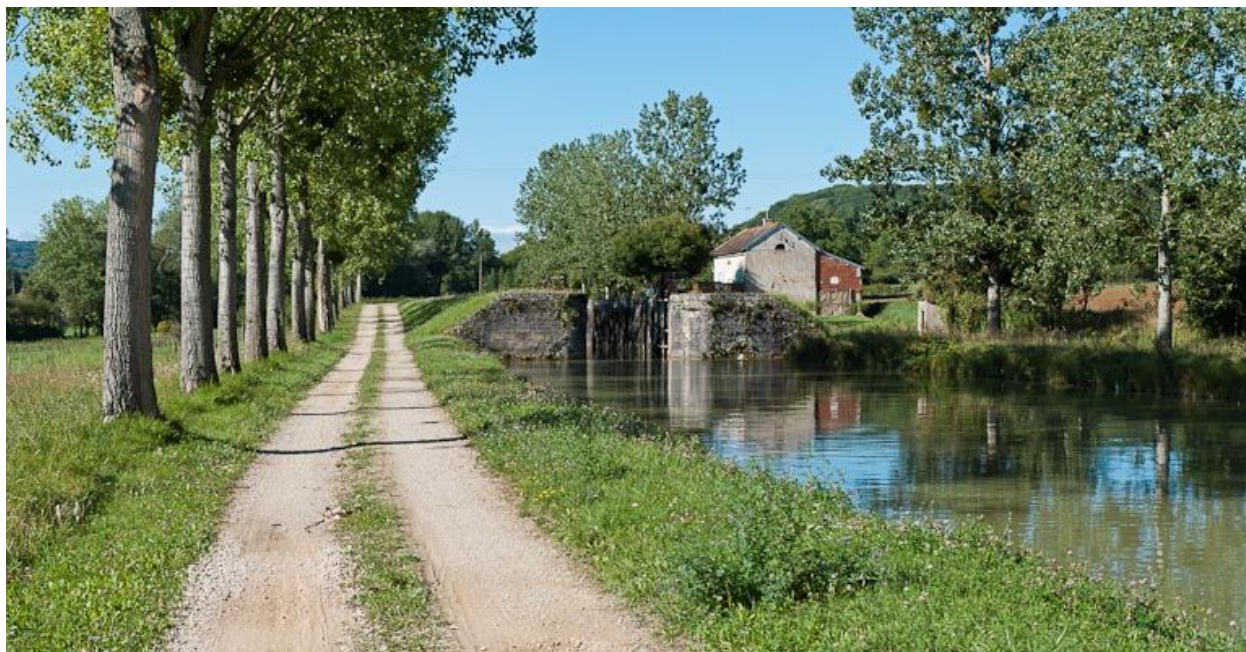
Vue du site d'écluse depuis l'aval.
