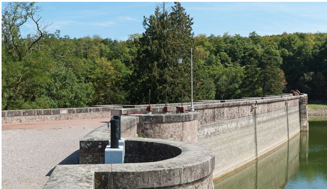
Vue de la digue du réservoir.
