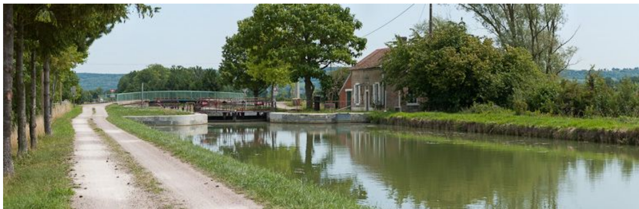
Vue d'ensemble du site d'écluse.
