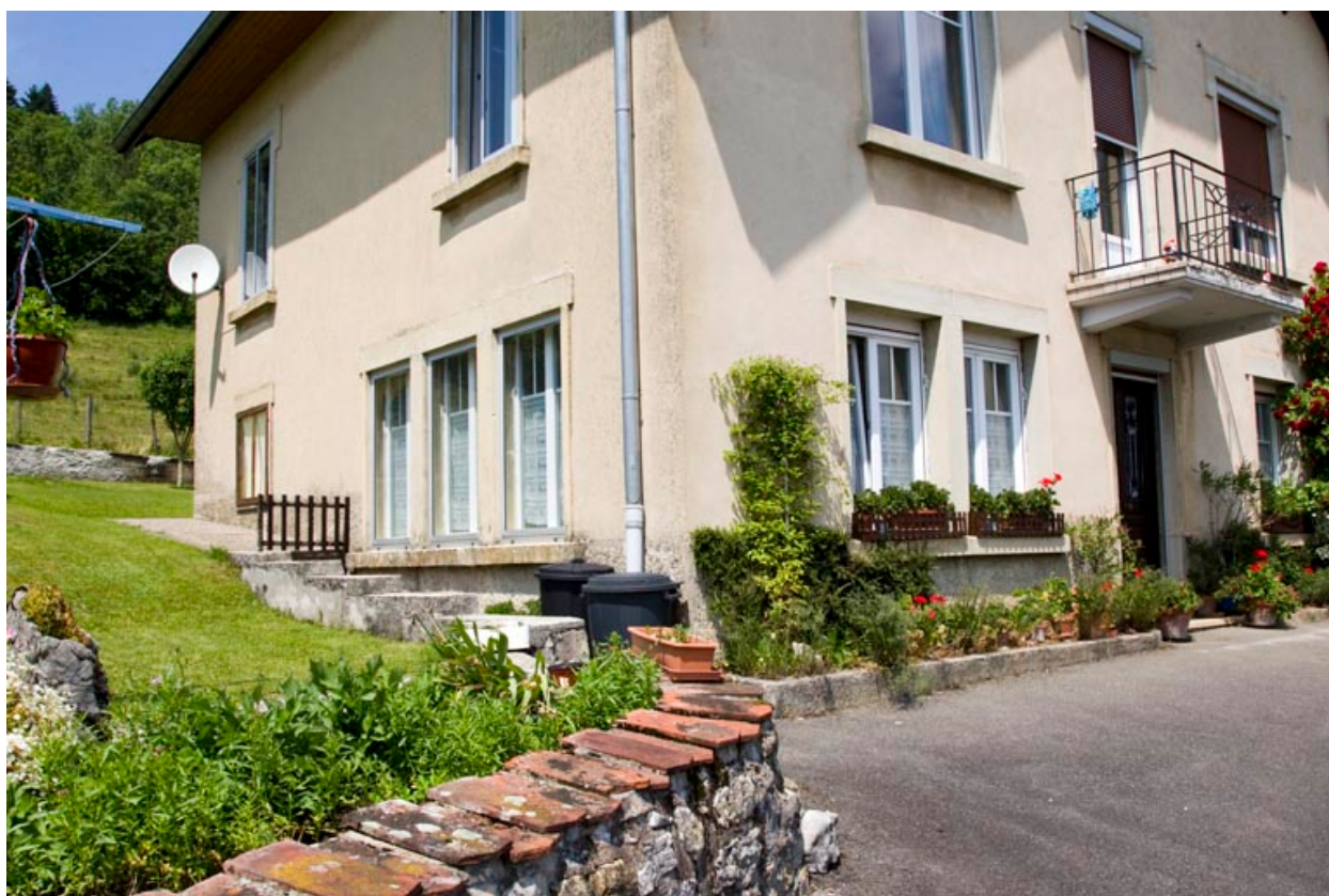
Fenêtres de l'atelier.
