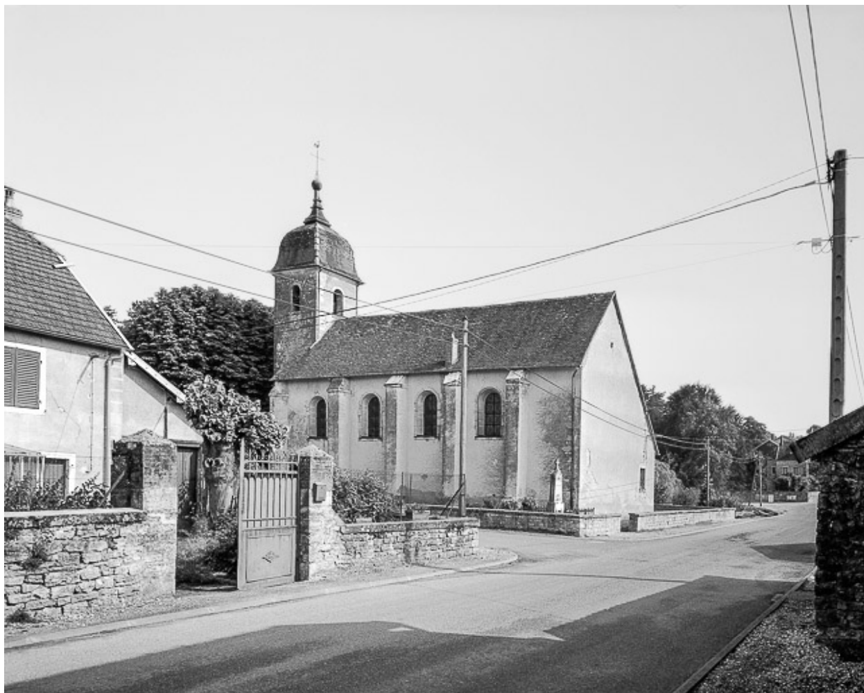
Façade latérale droite et chevet.
