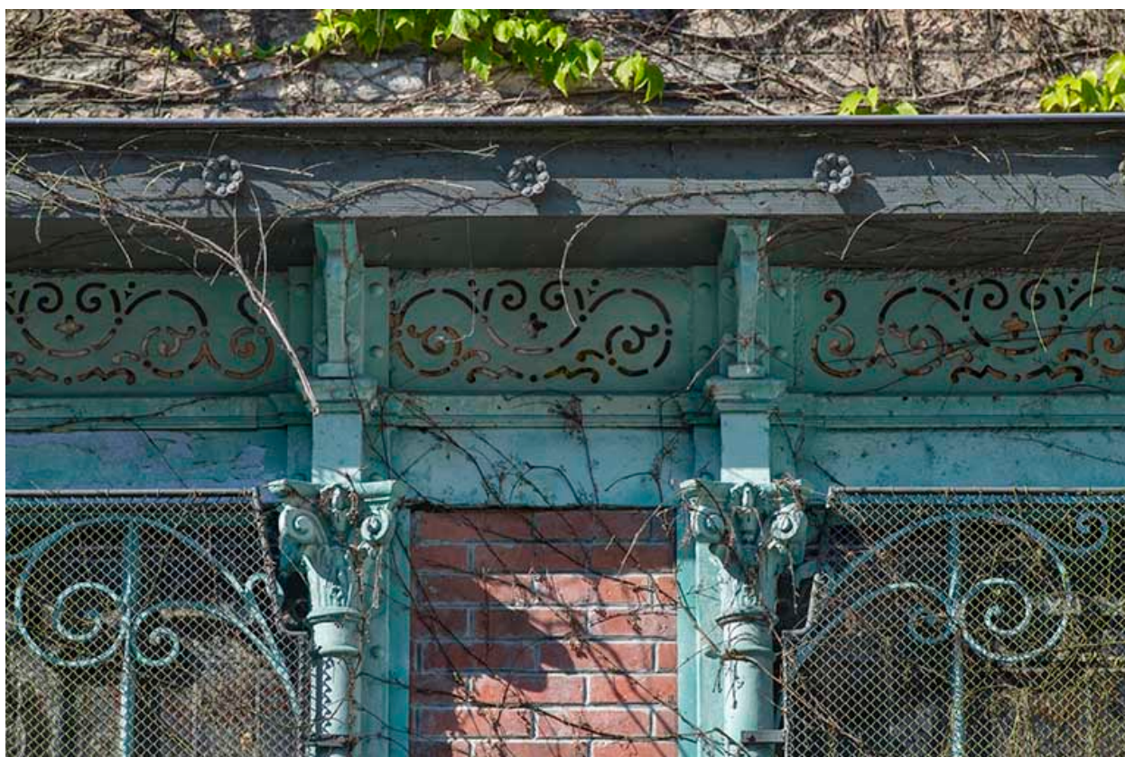
Jardin d'hiver (salle de bridge), détail.
