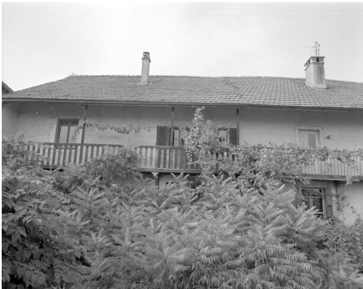
Façade antérieure, balcon.
