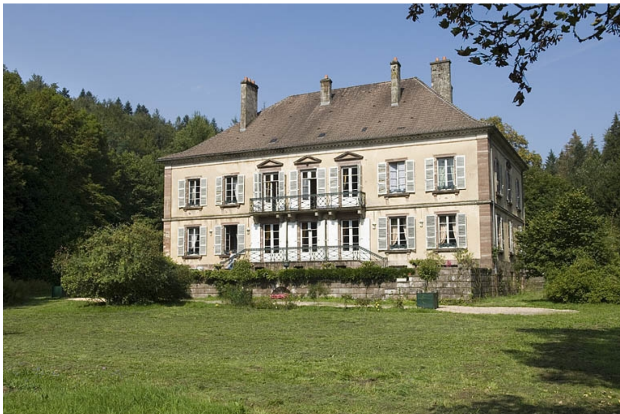
Façade sud vue de trois quarts droite.
