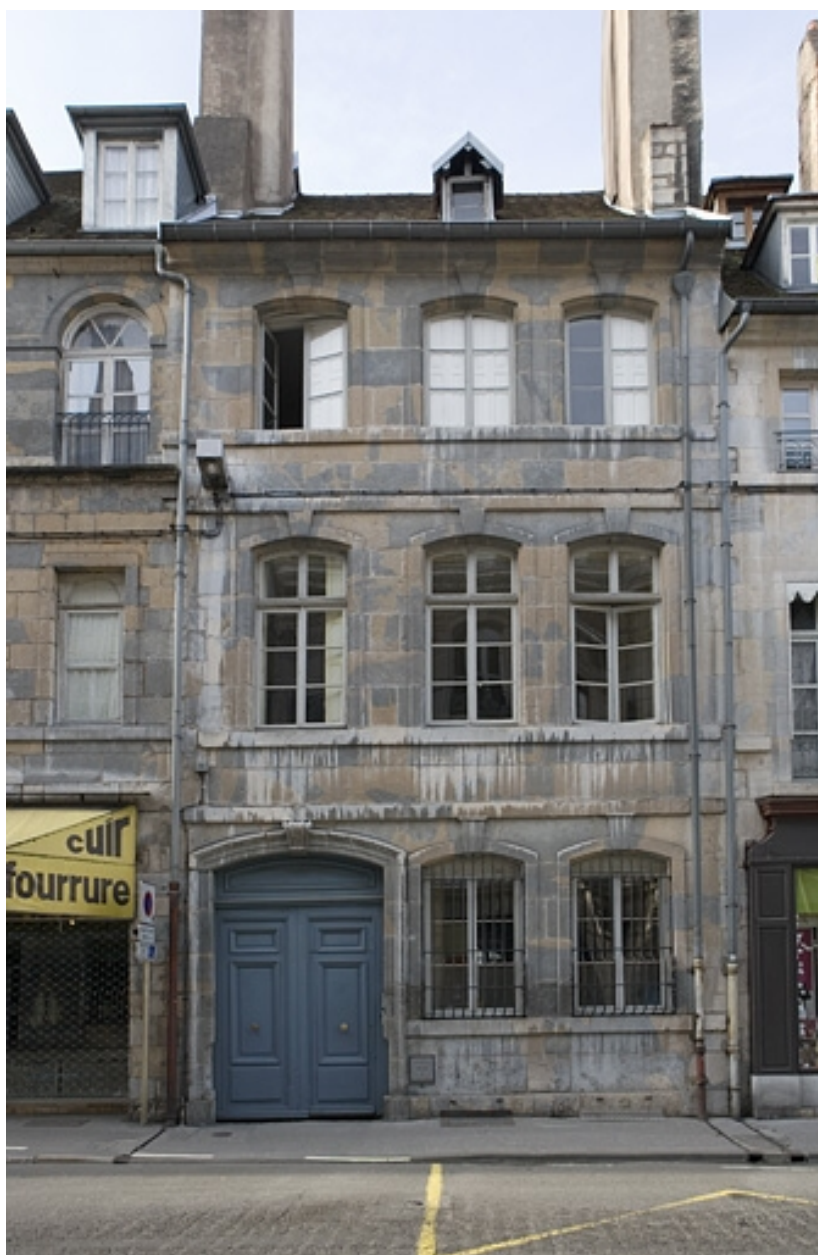
Façade sur rue, de face.
