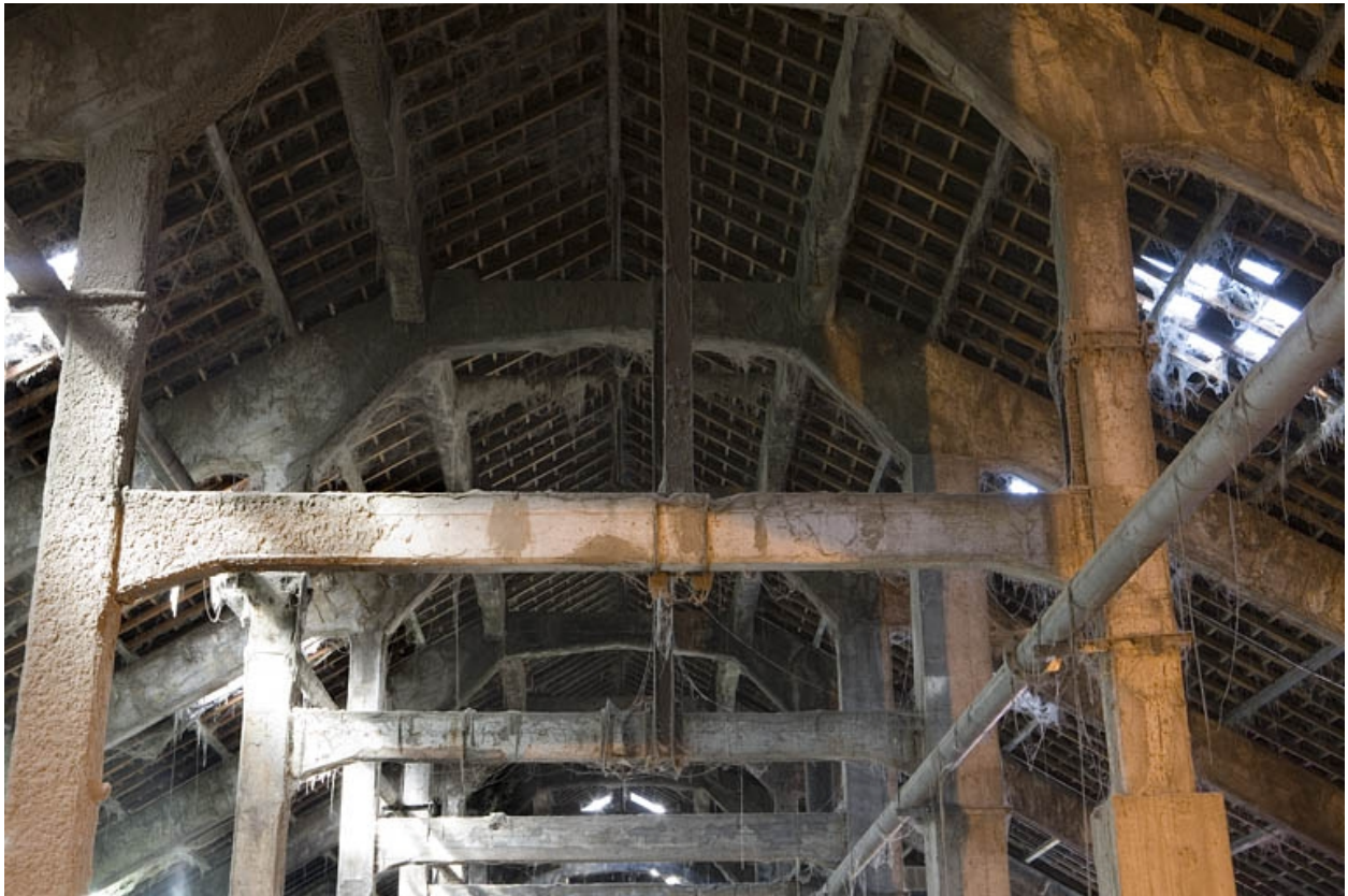
Atelier de trituration. Fermes en béton de la travée centrale.
