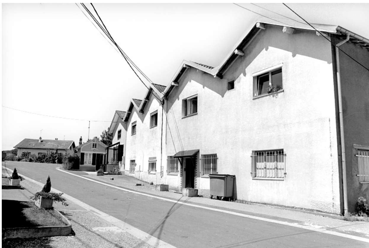
Murs-pignons des ateliers de fabrication.
