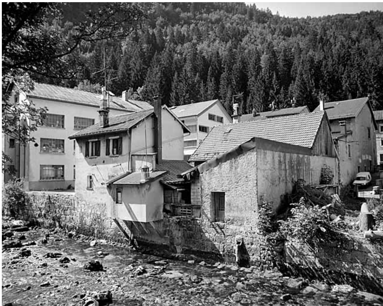
Vue d'ensemble, depuis le nord-est : élévations postérieures.
