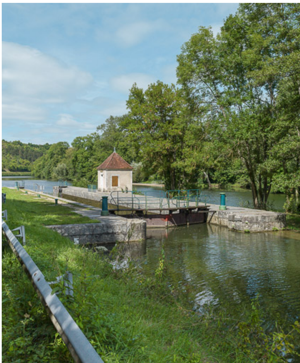
Vue du site d'écluse.
