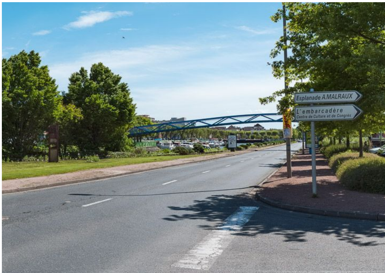
La passerelle avec le port.
