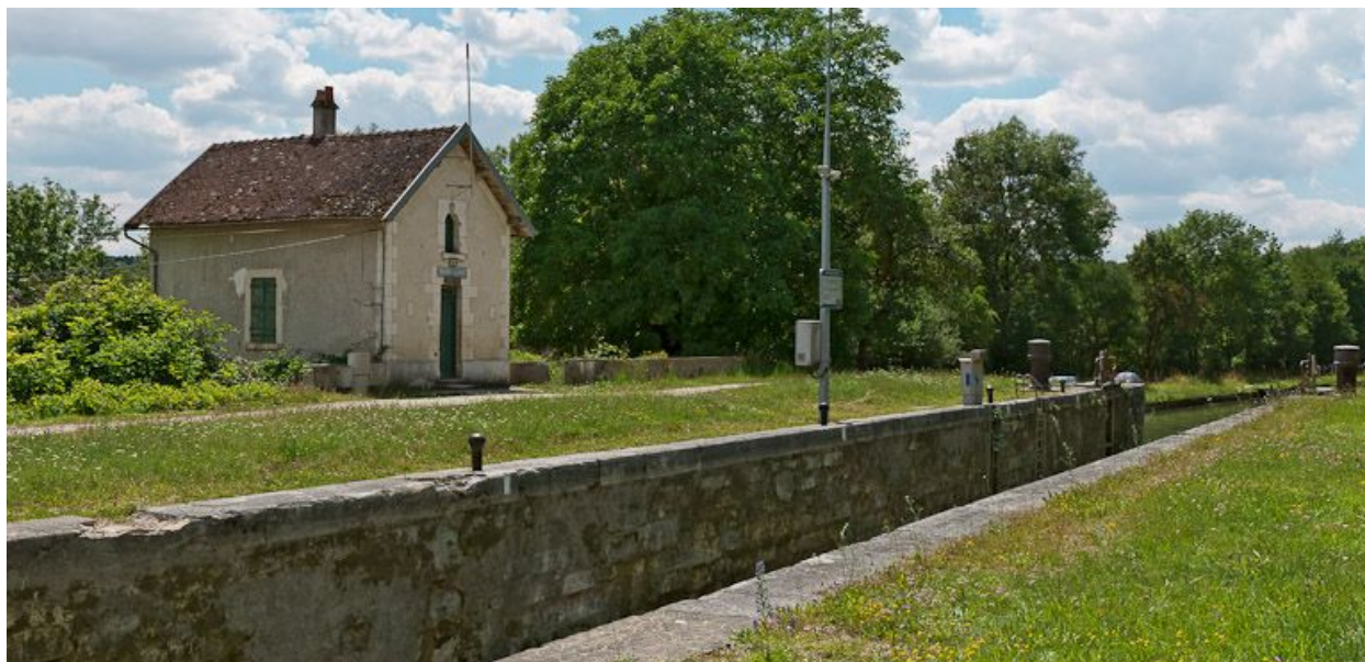
Vue d'ensemble du site d'écluse.
