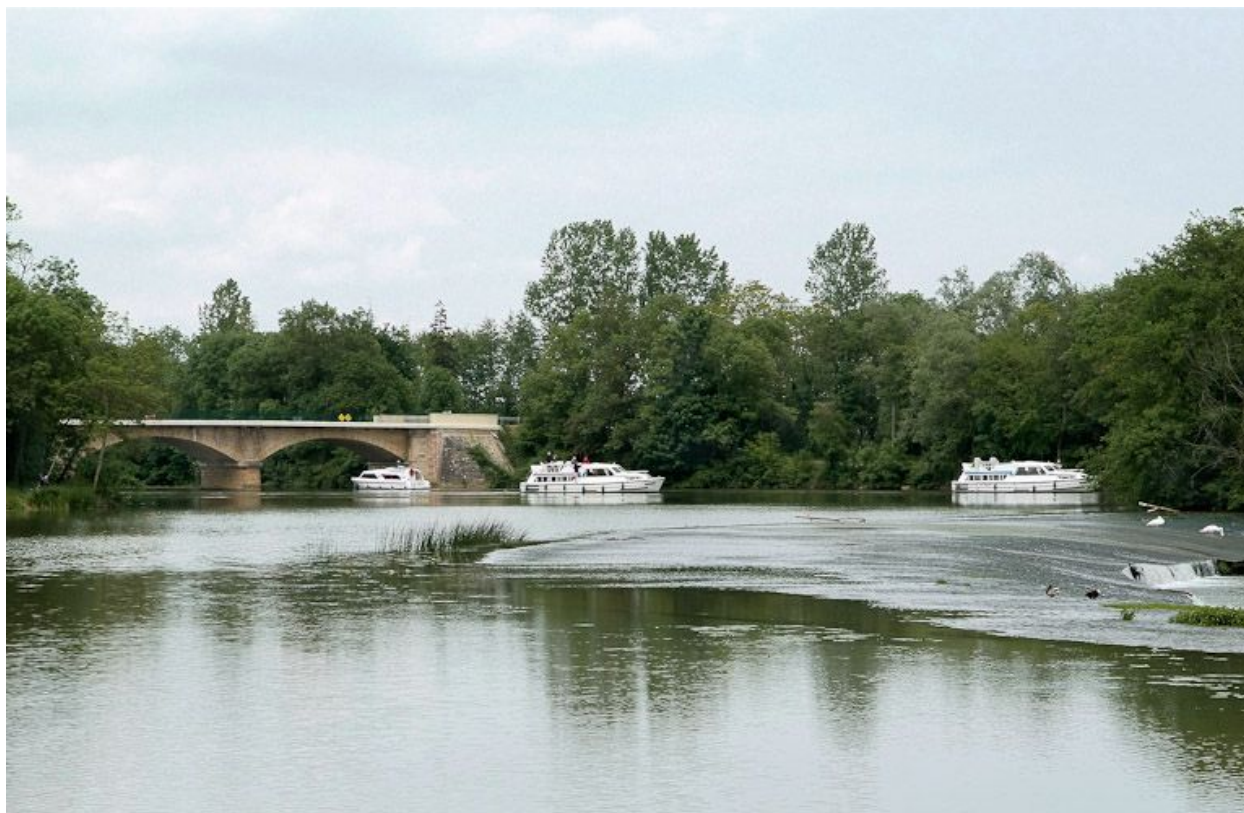
Le pont de Cuisery, vu d'aval.
