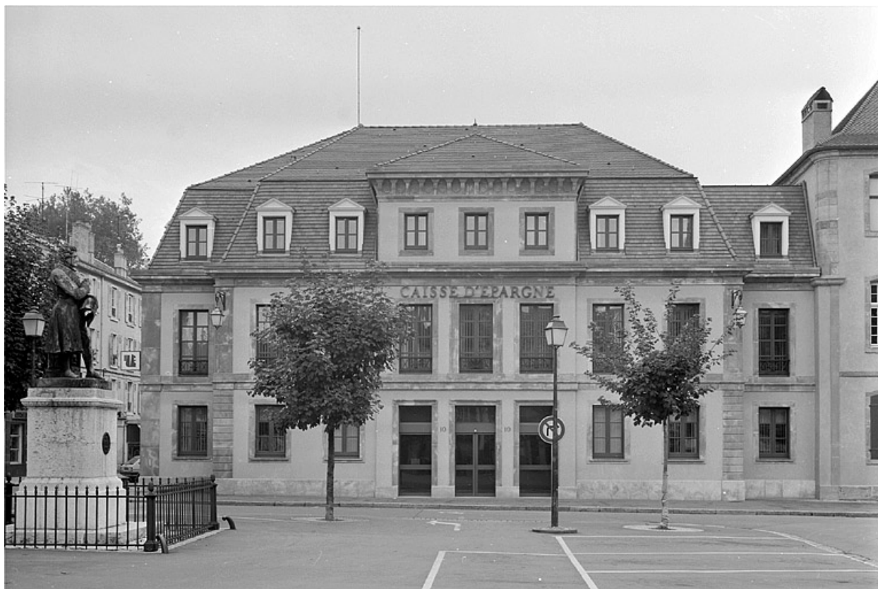
Façade nord après reconstruction.
