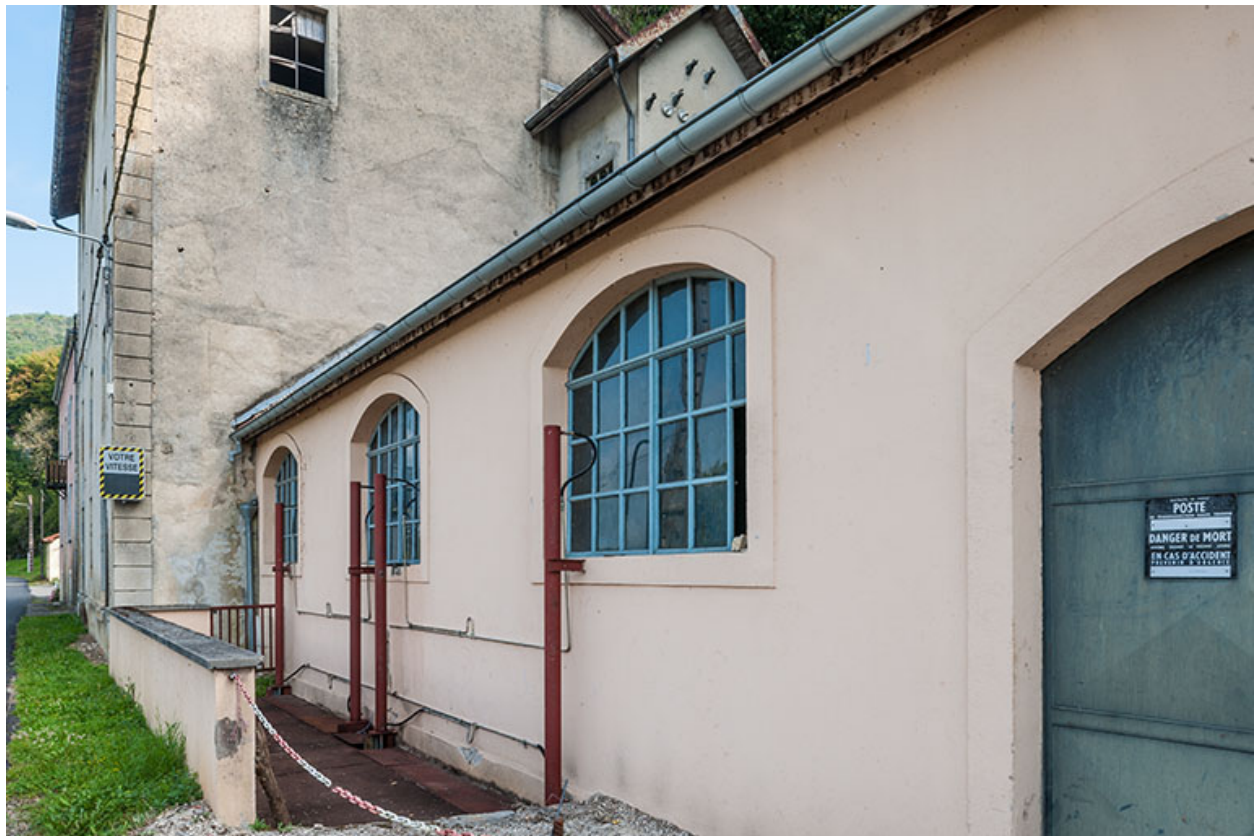
Vue rapprochée sur la centrale hydroélectrique.
