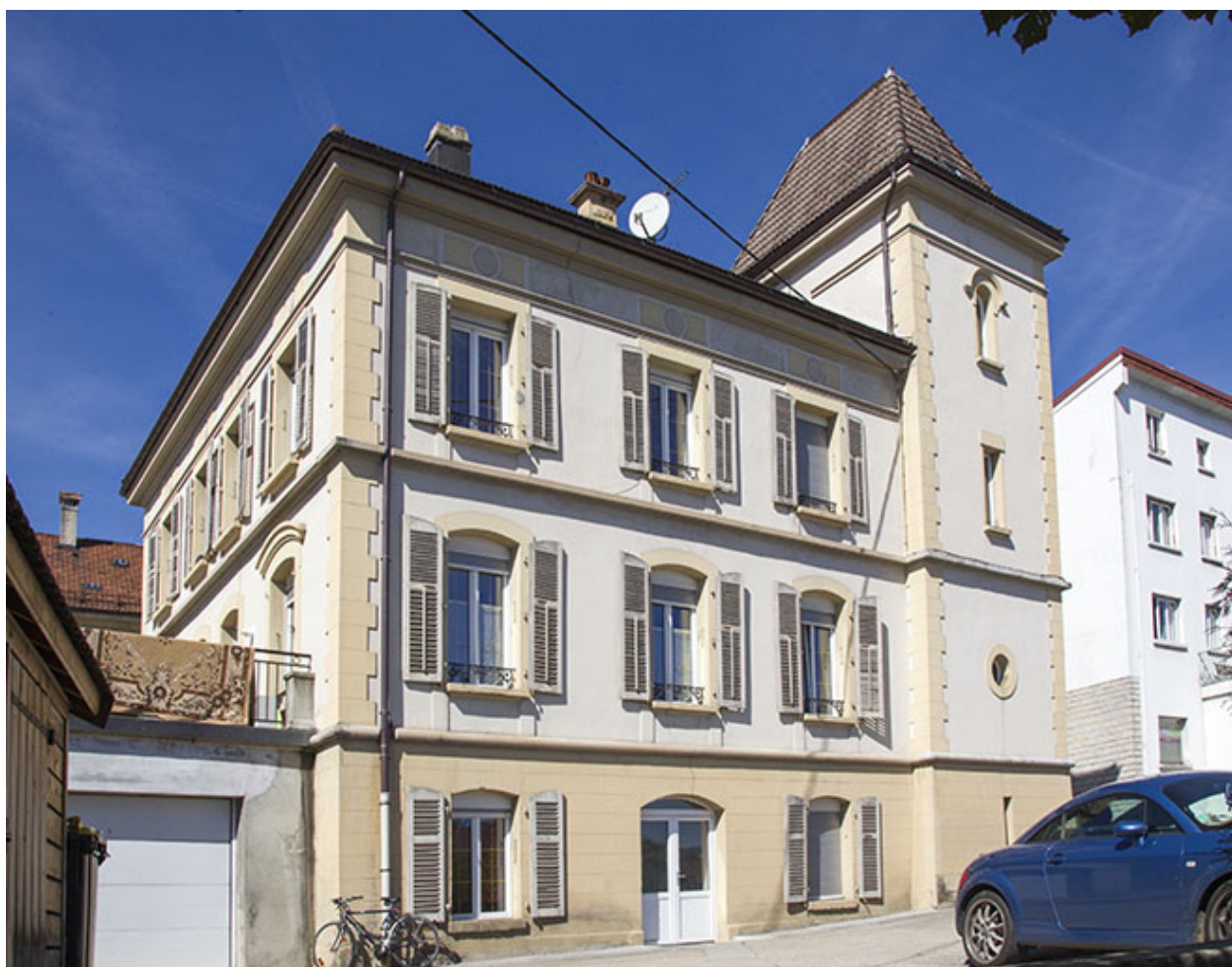
Façades postérieure et latérale droite.
