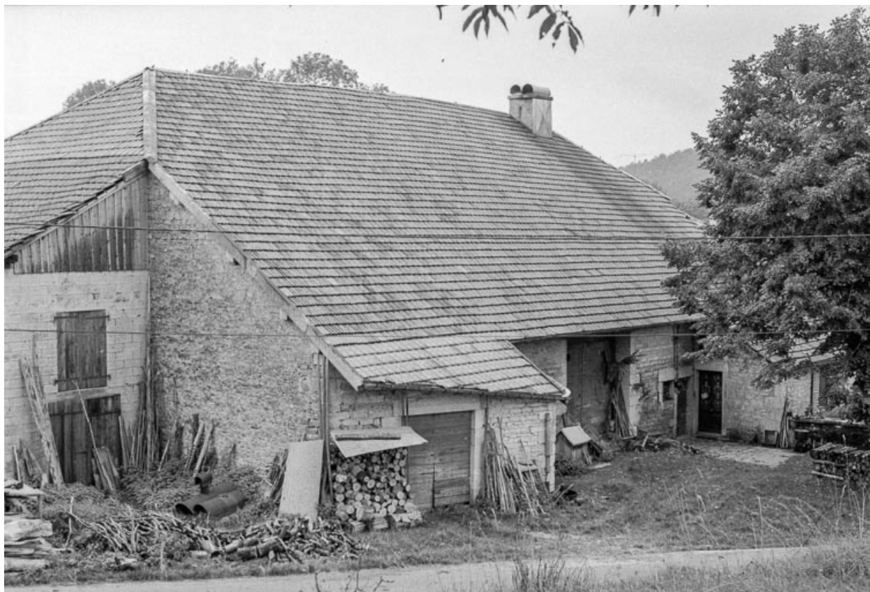
Ferme cadastrée 1939 F 28 : vue d'ensemble.
