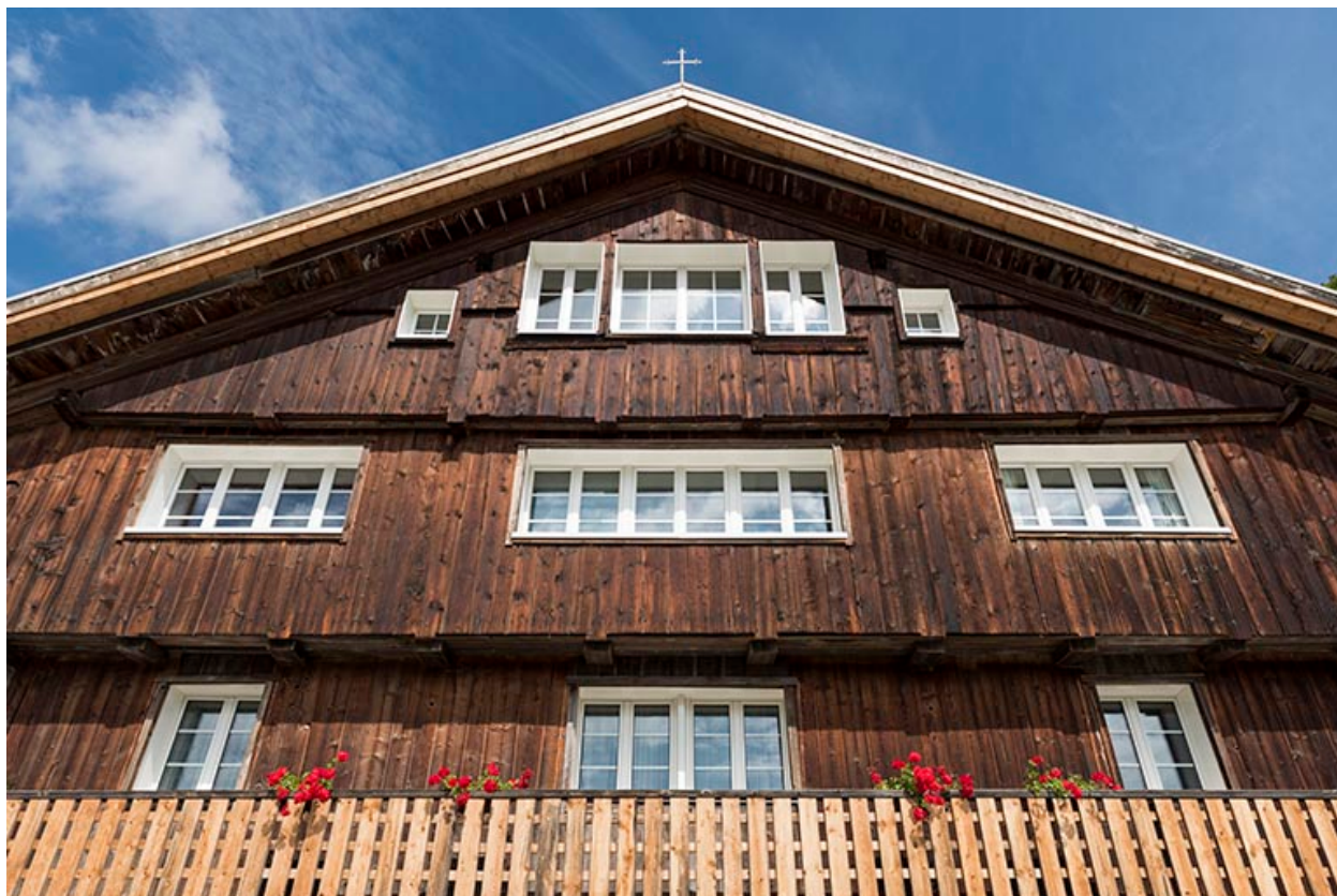
Façade antérieure, vue en contre-plongée.
