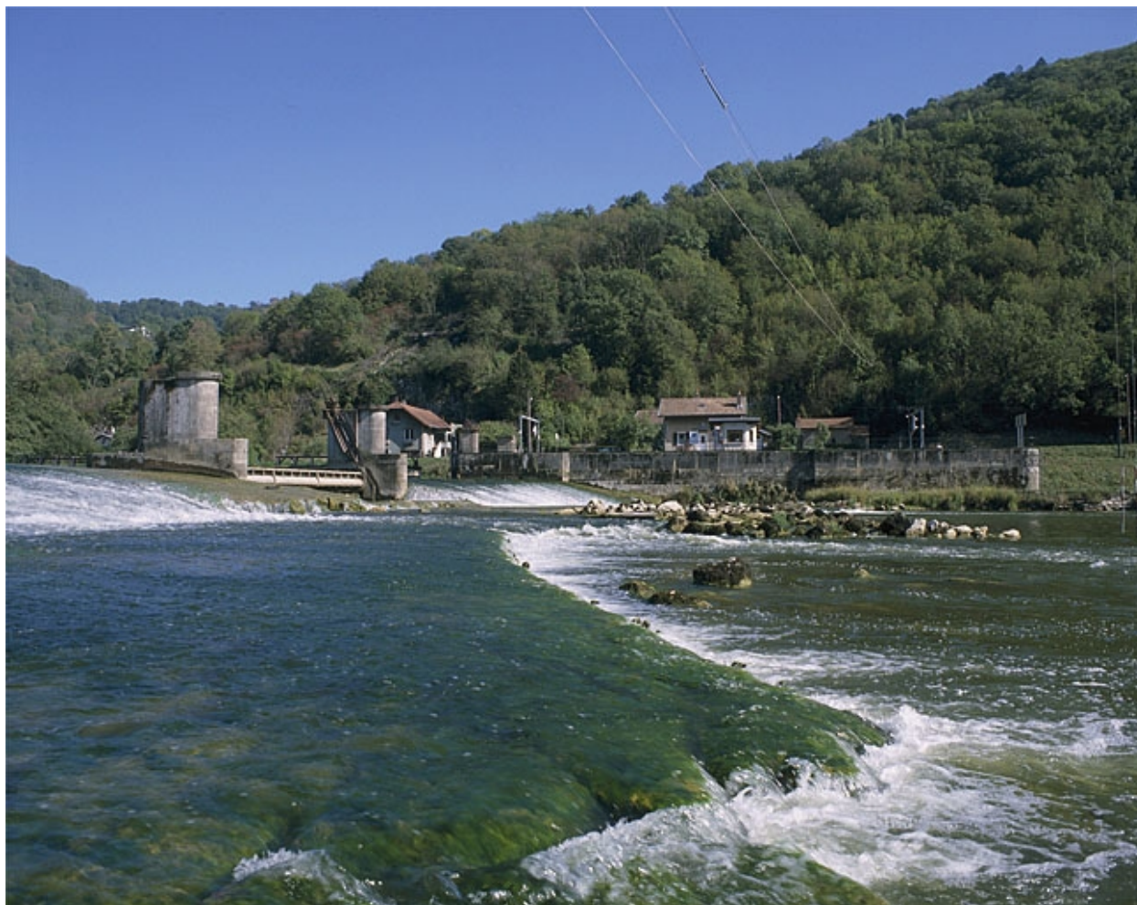
Besançon : site d'écluse n° 49 de la Malate.
