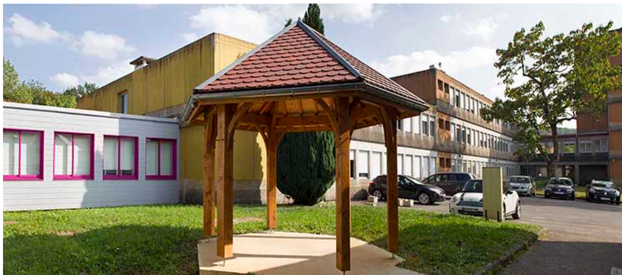
Externat : cour ouest.
