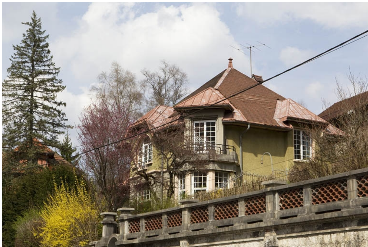
Logement patronal : vue d'ensemble, depuis le sud.
