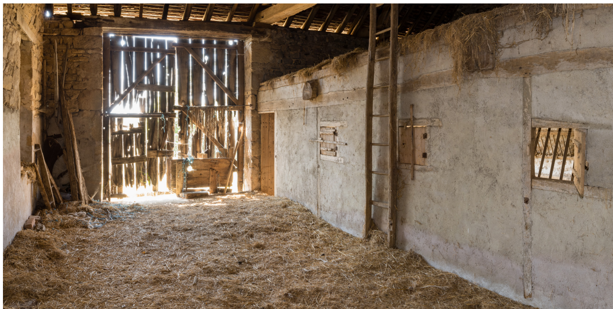
Vue intérieure du fenil.
