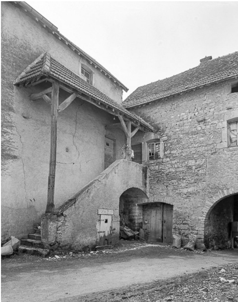
Vue de l'escalier extérieur.
