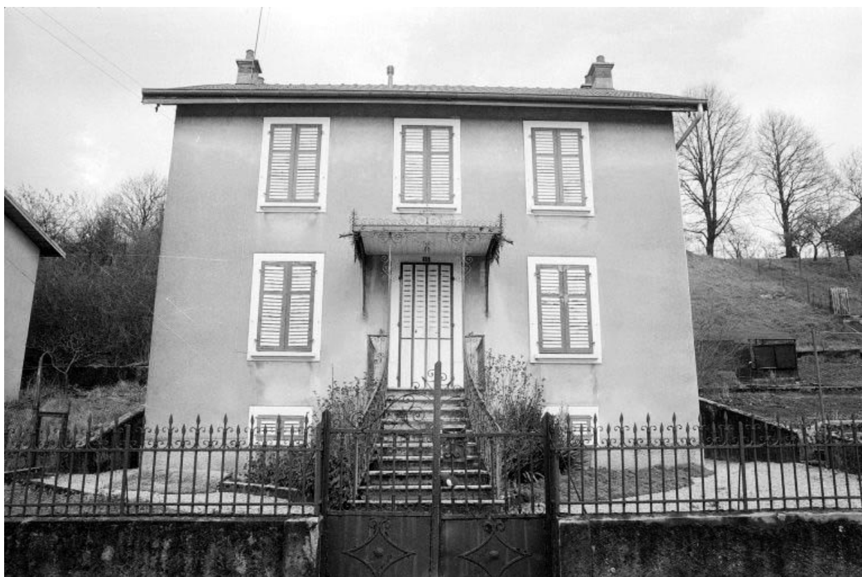
Audincourt : maison située 13 rue sous les Vignes.
