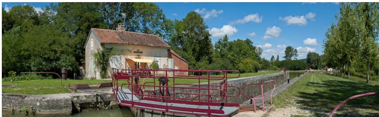
Vue d'ensemble du site d'écluse.
