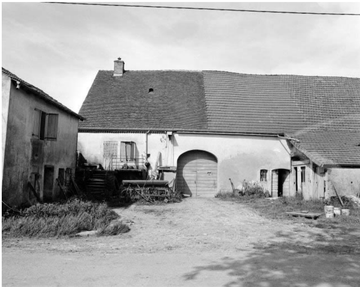
Ferme située Chemin de la Grange de Paille : façade antérieure.
