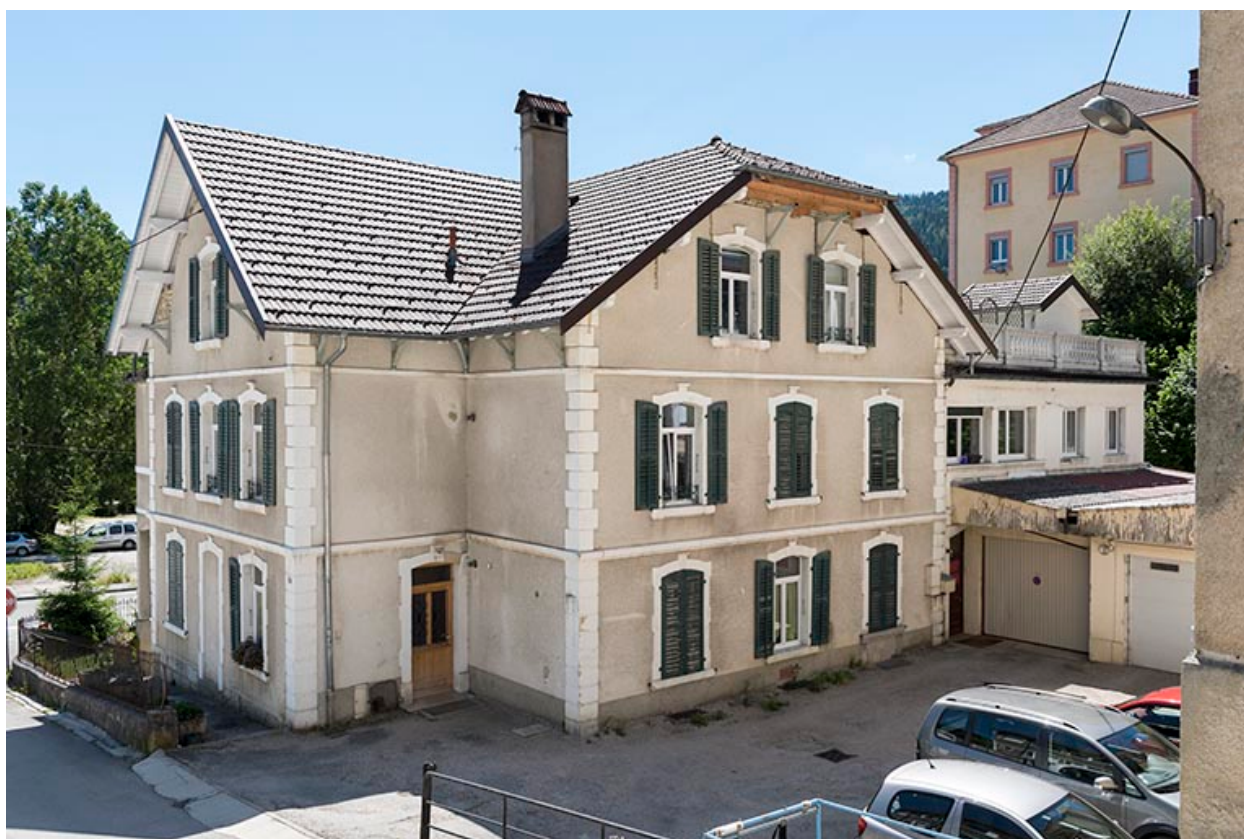
Maison : façades postérieure et latérale droite.
