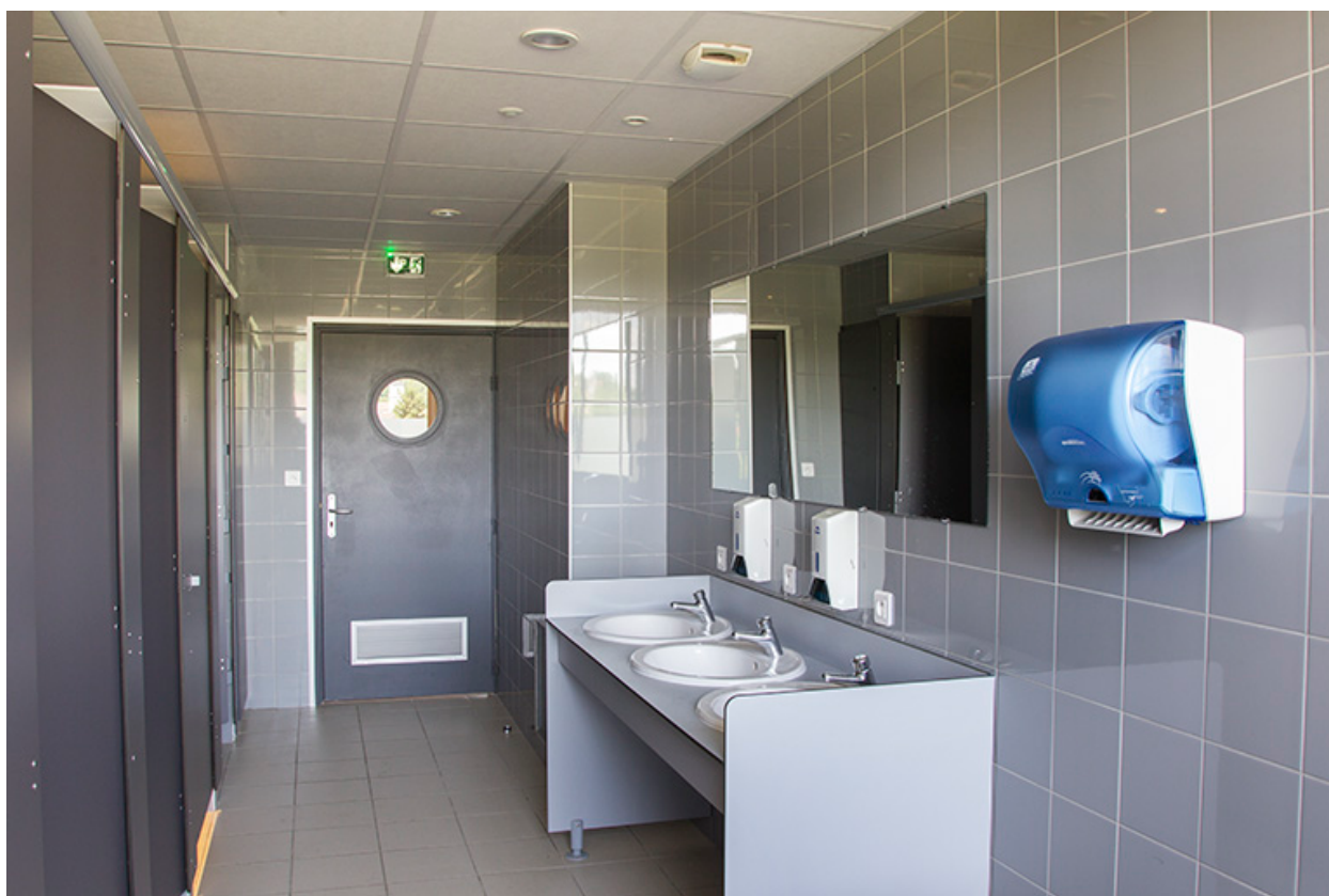
Salle de douches d'internat.
