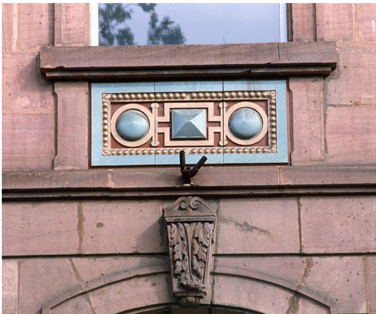
Façade principale, avant-corps, allège en céramique d'une fenêtre du premier étage.
