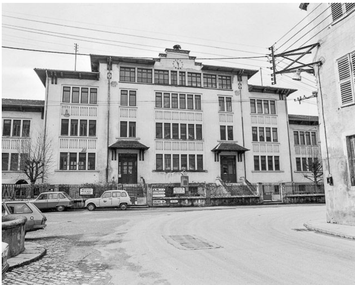
Vue d'ensemble (bâtiment détruit).
