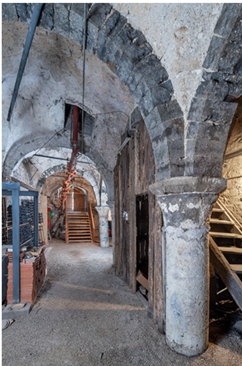
Vue d'ensemble de la cave, depuis l'est.
