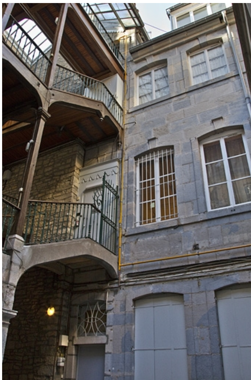
Façade postérieure du logis principal : vue d'ensemble.
