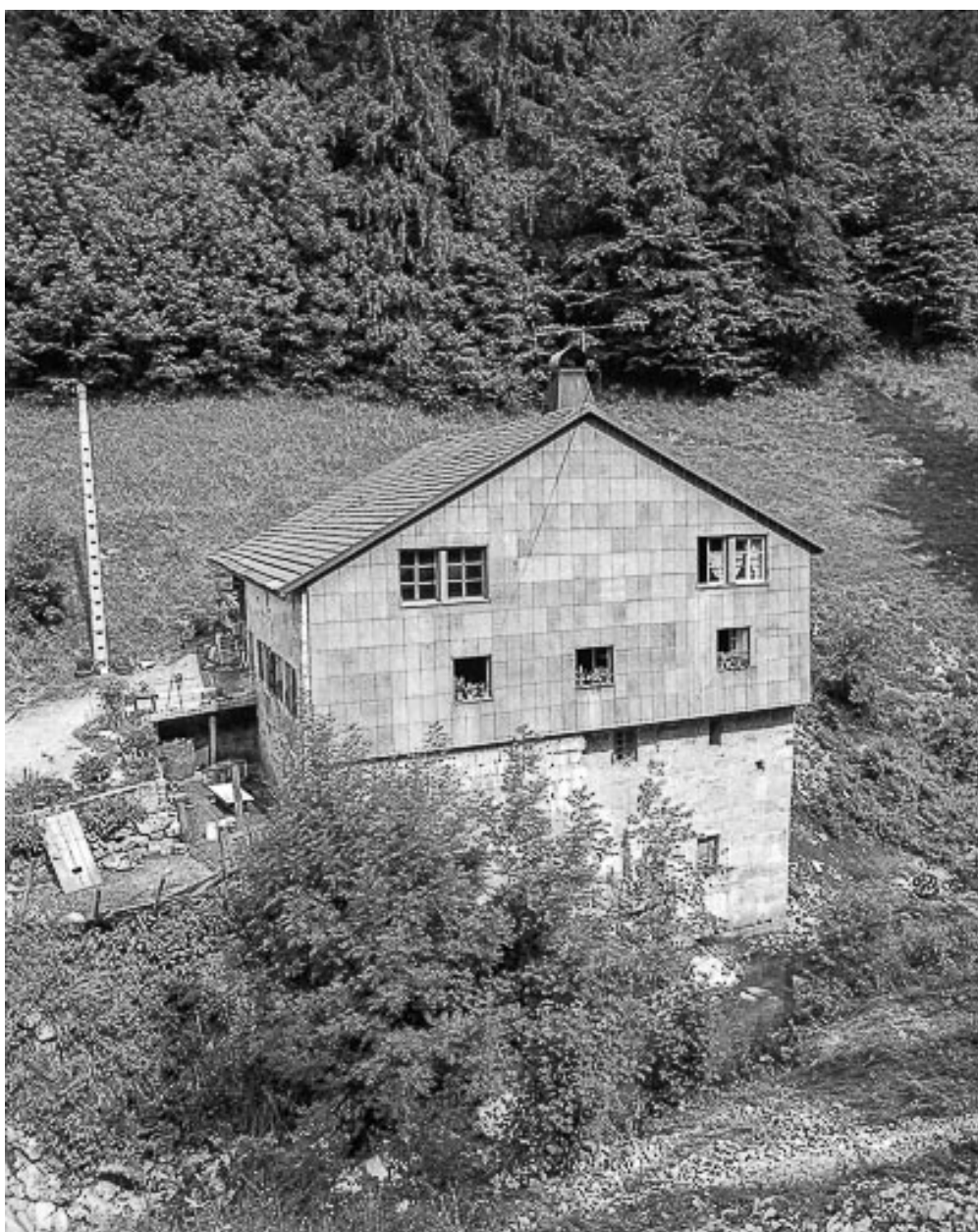
Ancien moulin : façade latérale droite, en 1976.
