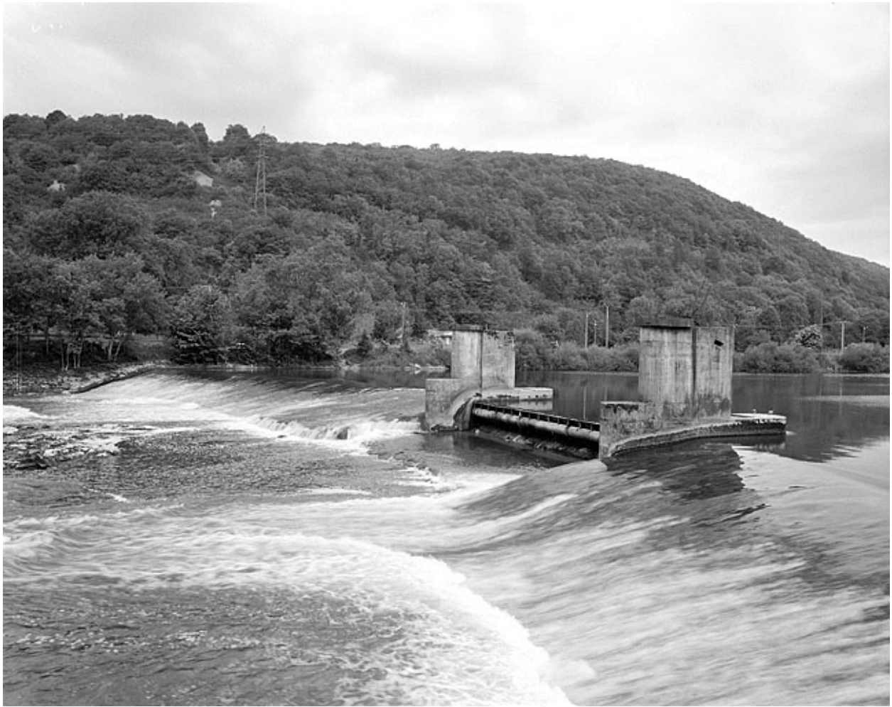
Vue d'ensemble depuis l'écluse, rive gauche.
