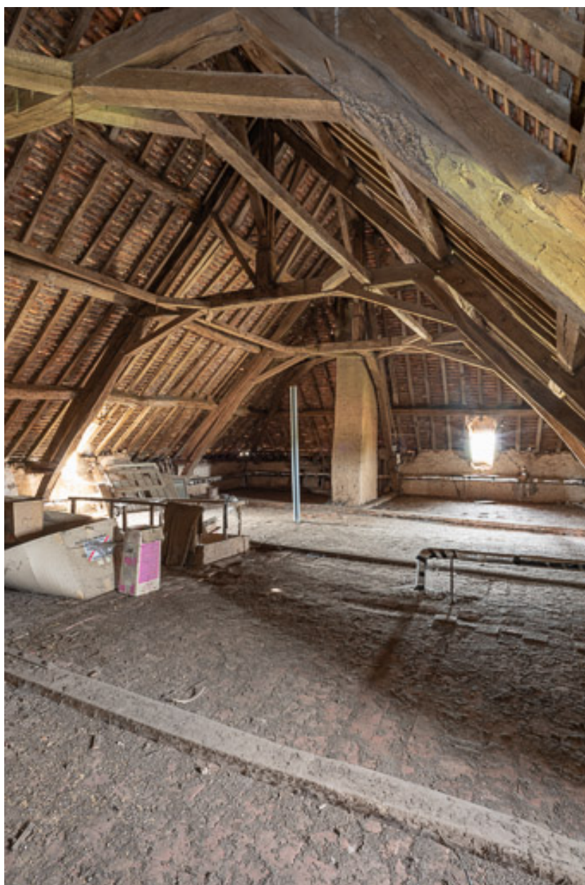
Vue de la charpente de la demeure
