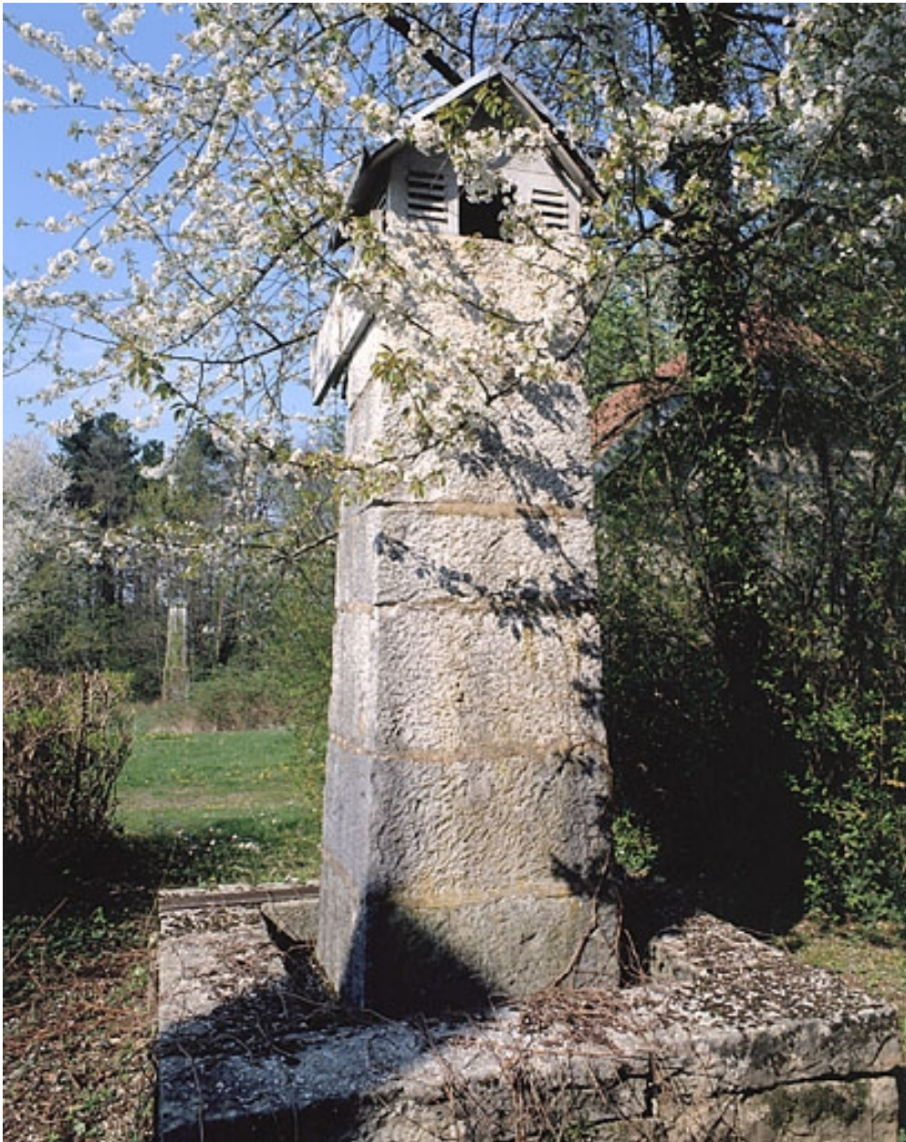
Piliers des mires nord de la lunette méridienne. Pilier sud au premier plan, nord au second.
