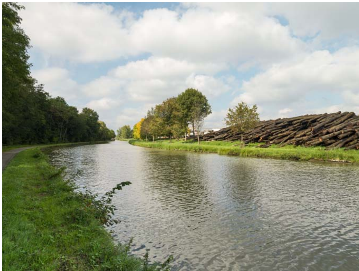
Vue d'ensemble de la scierie et du canal.
