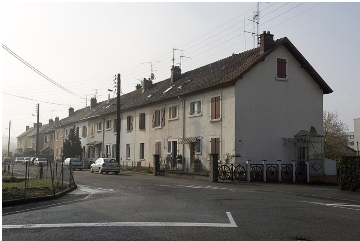
Logements ouvriers rue Paul Vinot.
