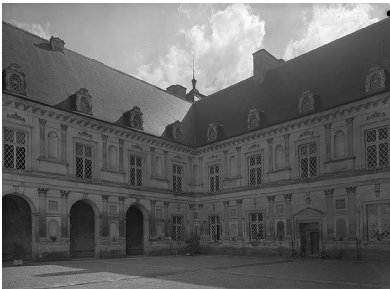
Façades sur cour (nord et est).
