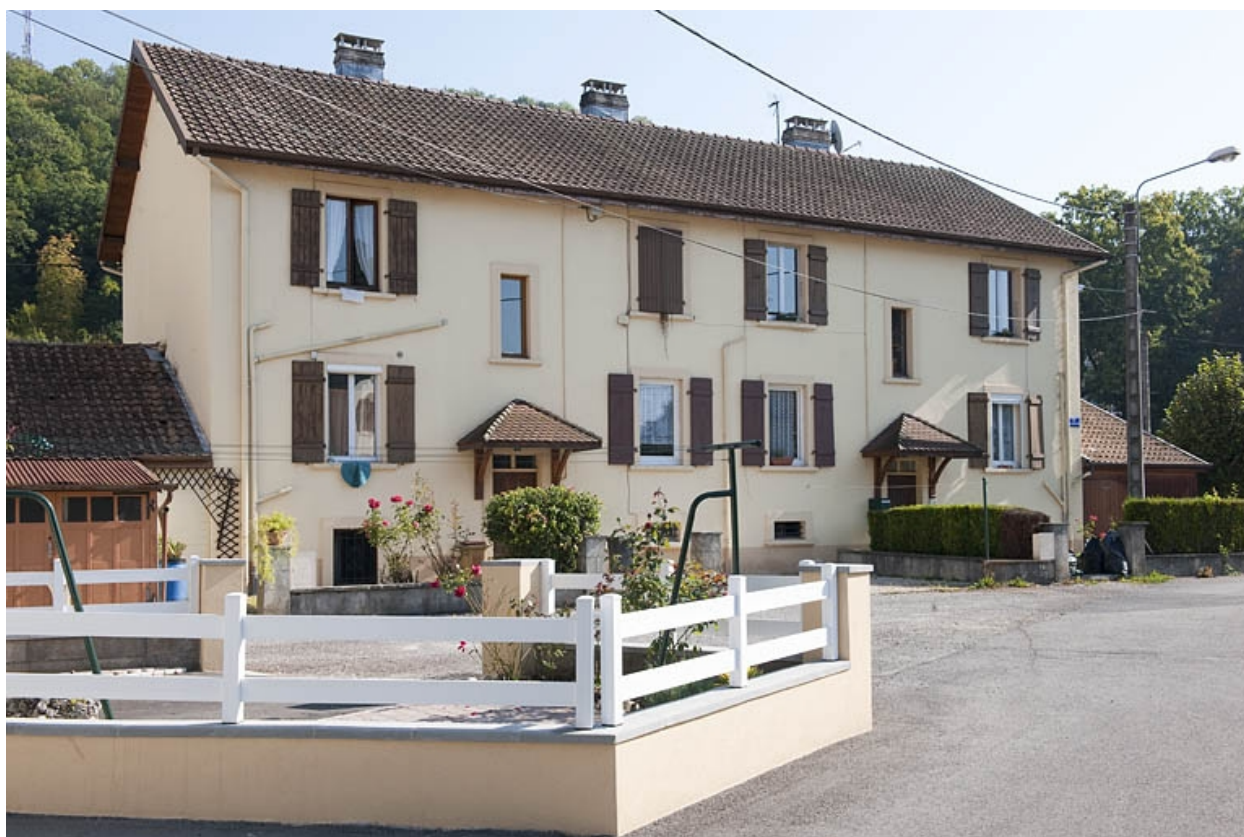
Façade antérieure d'une habitation.
