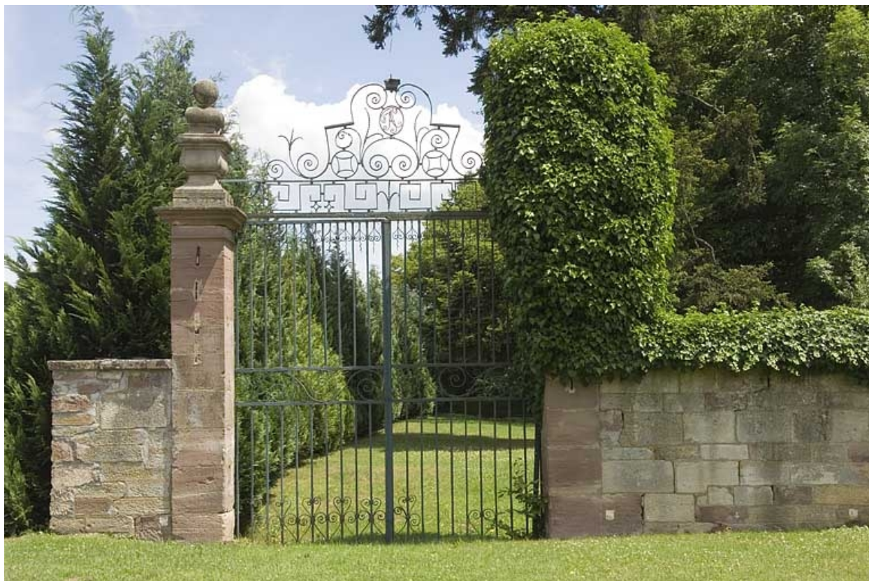
Portail en ferronnerie du parc.
