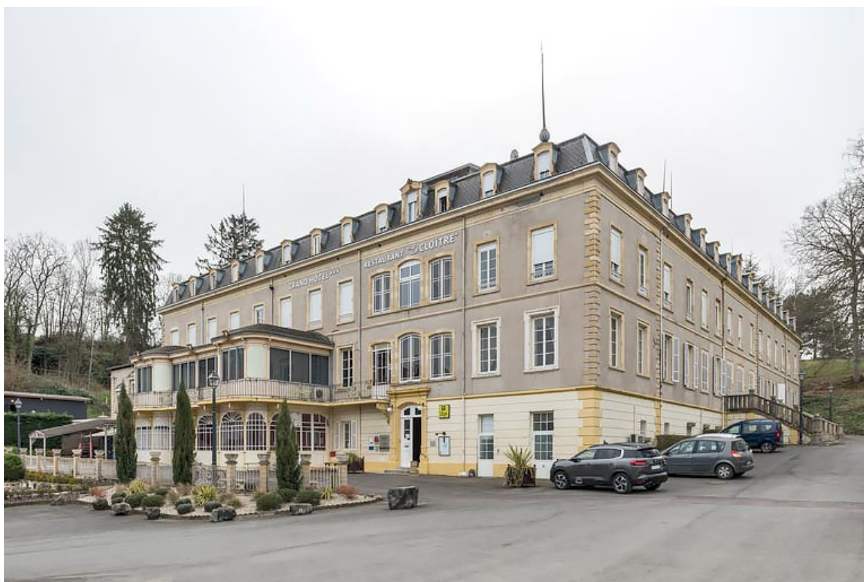
Aile ouest, vue d'ensemble.
