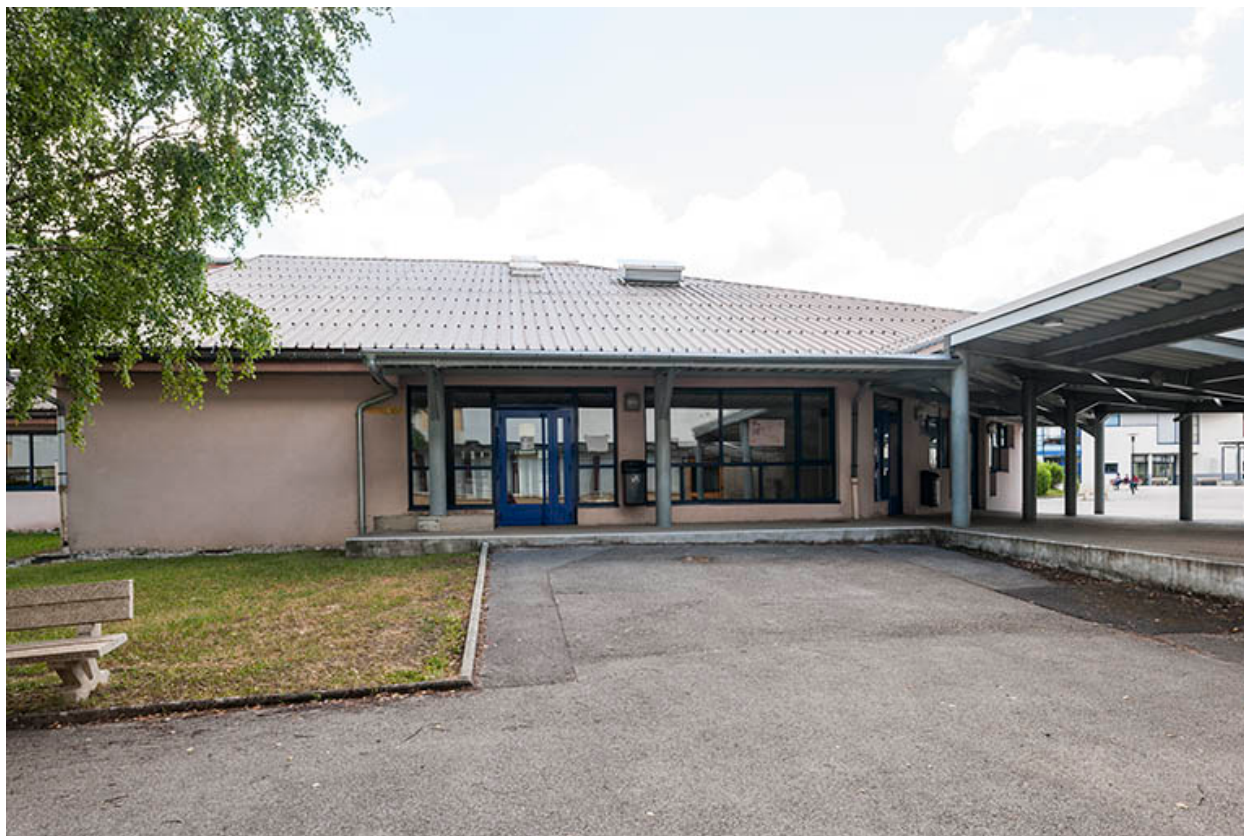
Restauration, façade Ouest, entrée.
