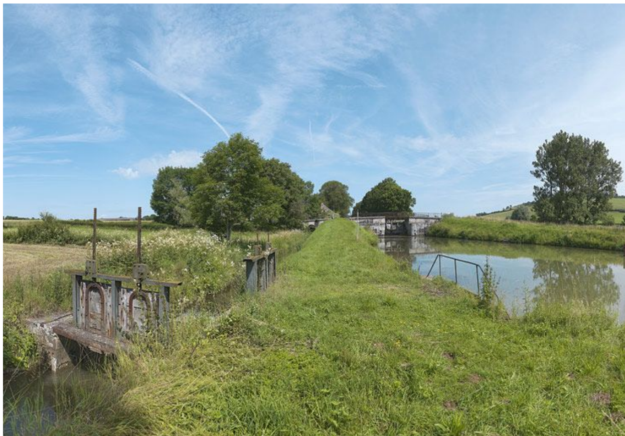
Réseau hydraulique autour de la rigole du Tillot avec arrivée d'eau dans le canal et vannes.
