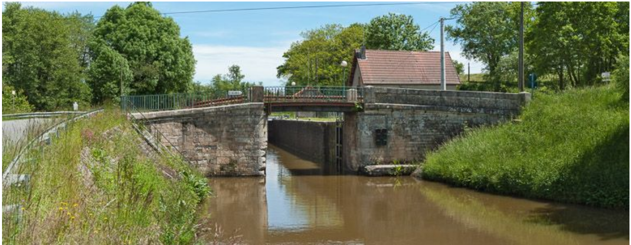
Le pont, vu d'aval.
